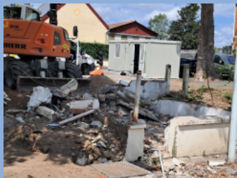
Destruction des anciennes toilettes.
