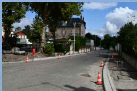
Reprise des trottoirs
